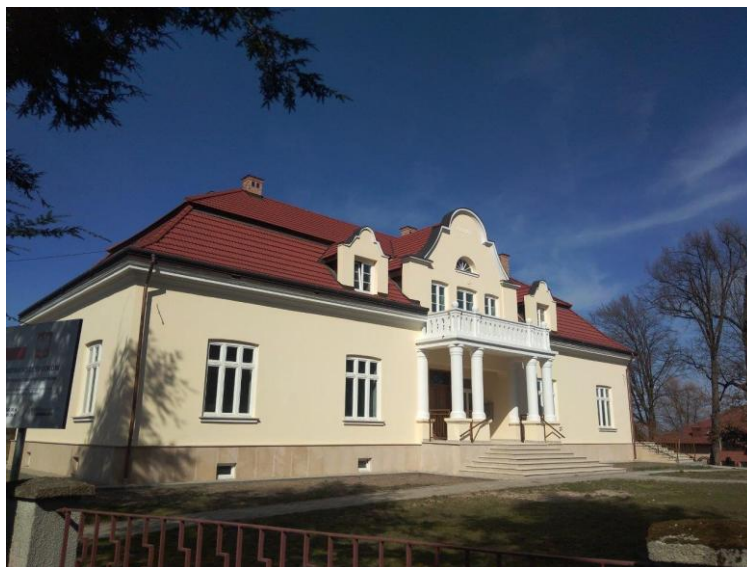
Zdjęcie nr 4. Budynek plebani z odnowioną elewacją
