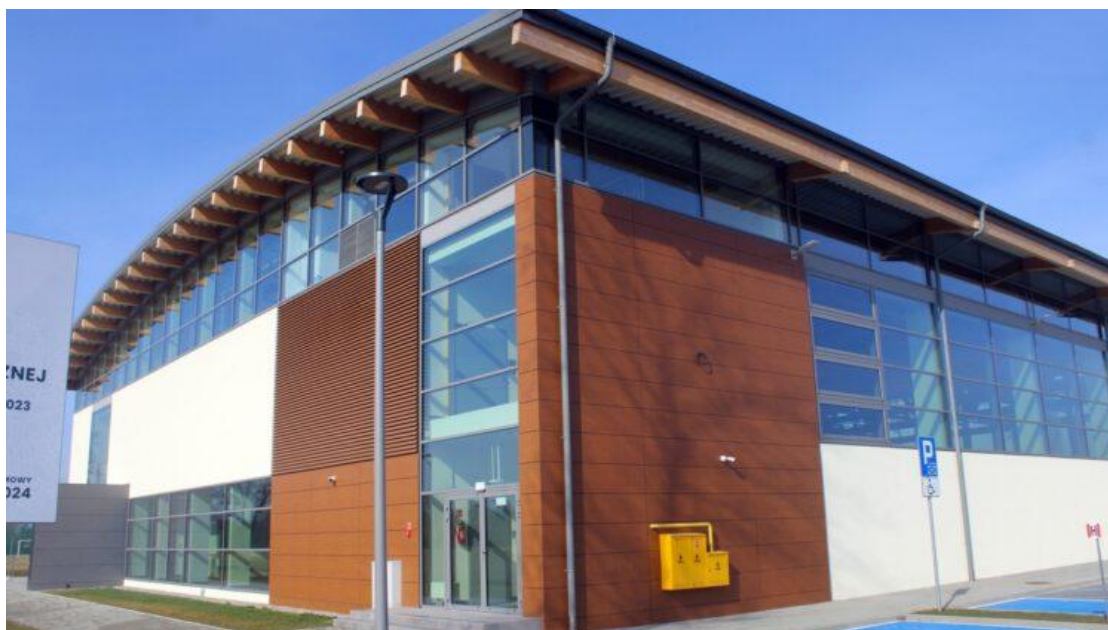
Zdjęcie nr 1. Budynek hali sportowej w Radłowie przy ul. Biskupiej
