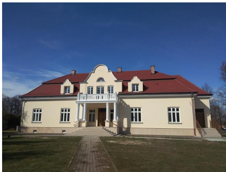
Zdjęcie nr 5. Budynek plebanii z odnowioną elewacją
