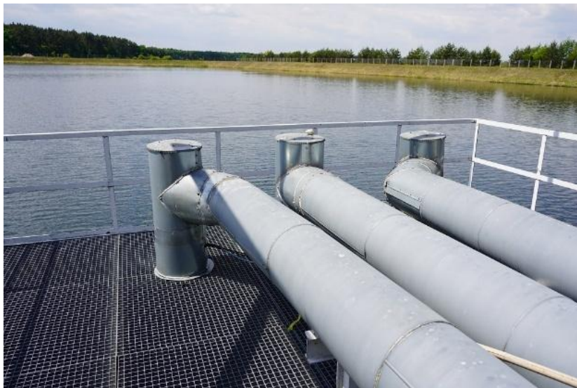
Zdjęcie nr 14. Przebudowa SUW-u
