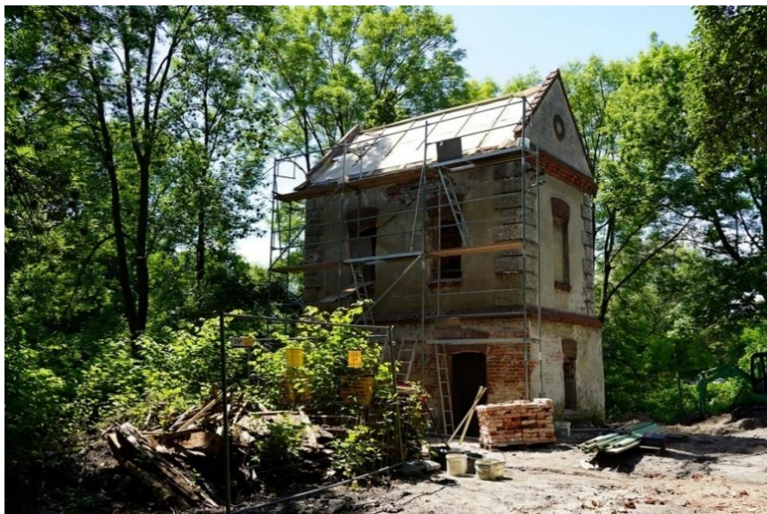
Zdjęcie nr 16. Prace remontowe przy Domu Ogrodnika
