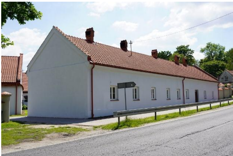
Zdjęcie nr 10. Budynek socjalny w Radłowie
