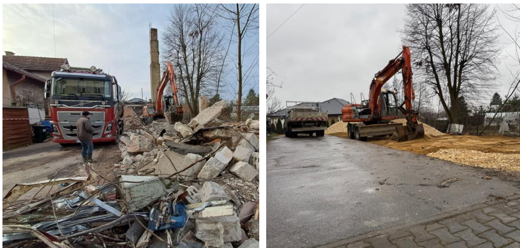
Zdjęcie nr 28, 29. Rozbiórka budynku garażowo-gospodarczego wraz z помещением котловни w Radłowie
