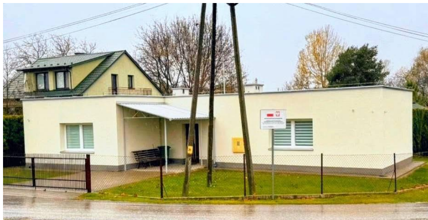
Zdjęcie nr 6. budynek Domu Ludowego po modernizacji
