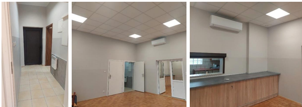
Zdjęcie nr 7, 8 i 9. budynek Świetlicy Wiejskiej w Siedlcu po remoncie
