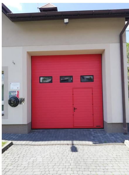
Zdjęcie nr 10. budynek Remizy OSP Siedlec po modernizacji
