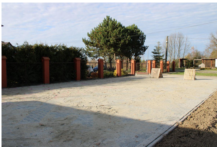
Zdjęcie nr 24. Utwardzenie terenu kostką brukową w Zabawie
